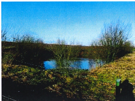
Le bassin d'orage de Ligney
