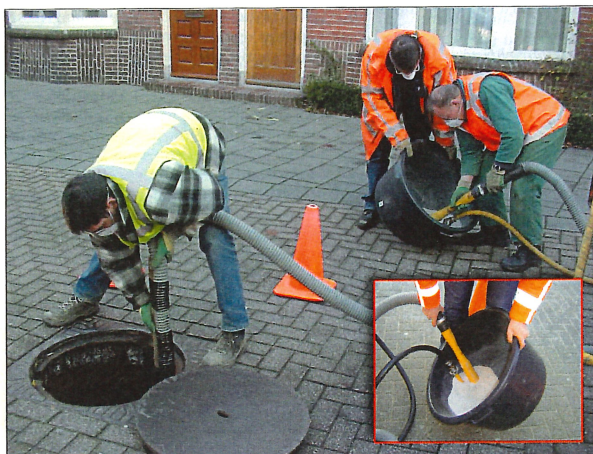
De korrelcocktail wordt in de riolering van het Nederlandse Tilburg gezogen. Om het vervoer van het product naar de riolering te vergemakkelijken, wordt het eerst in een kuip gegoten (inzet).
