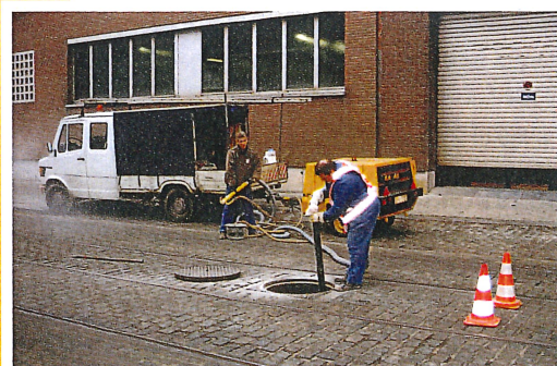
Uitstrooiing van BIO COL in hoofd collector van gemeente Vorst in Brussel. BIO- COL is financieel en ecologisch interessant voor de ontslibbing van rioleringsnetwerken.
